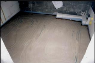
Yerden ısıtma sistemi üzerine koruyucu beton ile üzeri şap uygulaması
