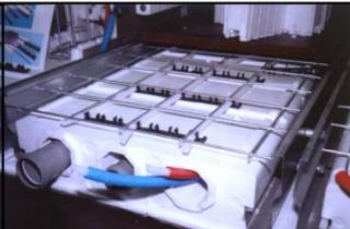
Tesisatlar elektrik, kalorifer veya yerden istifa gibi tüm donanımların alt yapısı beton dökülmeden önce hazırlanabilir.
