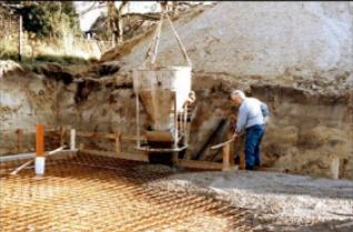
Temel B.Abetonu dökülür.Temel çok hassas mastarlanmalı düzgün ve kotunda olmalıdır.
