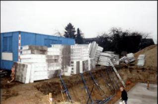
Şantiyede montaj ve iş iskeleleri ile İzkal kalıcı kalıplar tedarik edilmiş ve montaja hazır olmalıdır.Izkal kalıplann istiflenmesinde gurulama yapılmalı ve kesinlikle elemanları rüzgarдан korumak için tedbir alınmalıdır.
