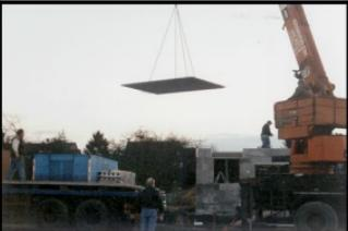
Dışarıda hazırlanmış filigran betonarme döşeme panelleri vinç yardımı ile izokal taşıyıcı betonarma perdeler üzerine monte edilir.
