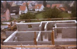
Beton dökümü için hazırlamış izikal taşıyıcı duvar kalıcı kalıbına. Beton pompasıyla ve bir darbe engelleyici destekle yada çıkış ağzındaki bir indirgeyiciyle beton dökülmelidir
