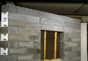
Kemer kesilen parça ile kapatılıp alttan dikme ile desteklenir
