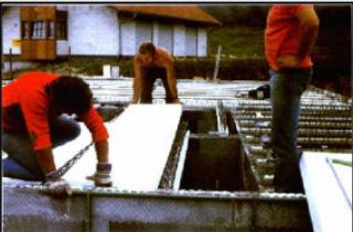
İzokal taşıyıcı beton perde duvarlar üzerine Arfa izokal floor asfalten tavan döşemesi elementleri döşenir. Prefabrik taşıyıcı JJ döşeme kırşları ve İzokal asfalten elementleri beraber montajlanır.
