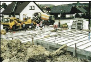
Alternatif olarak her türlü döşeme sistemi Arfa izokal taşıyıcı masif duvarlar üzerine yapılabilir. (Baplak, ahşap çelik kiriş, diğer klasik asfalten döşemeler vb) döşeme betonunun iyi testiye edilmesine ve kotunda özen gösteriniz.
