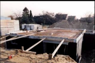
Dış duvarlarda izokal L bitirme kalıp elamanı kullanılır.Böylece döşemedede ısı köprüsü olusturan riskli bölgeler izolasyonu kavuştur.statik programa göre donatı yerleştirilir beton dökülür..
