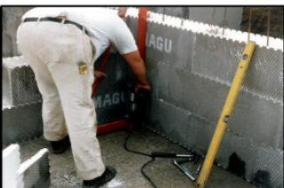
Üçüncü kalip dizisinden sonra ARFA montaj iskelesi kolonları duvara geçici destek ve beton dökümünde iskele olarak kullanılmak üzere ip istikameti boyanca taban plakasına montaj vidası ile tutturulurlar.
