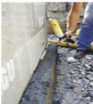
Duvar istikameti her iki taraftan polüretran köpük ile (solven içermeyen) veya kalıp tabanına içeren yaklaşıklık 5 cm betonla doldurularak beton doldurulması için hazırlanır.
