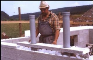
İç taşıyıcı izikal duvarlar üzerine 5 cm lik tesviye elemanı montajı gereklidir. Duvarlarda tesisat boruları veya panoları işlenebilir
