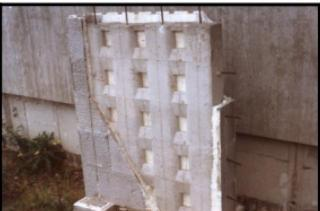
Mevcut yapıları güçlendirmede izokal Kalıcı kalıplar kullanılır. Kolon kırış arasındaki dolgu duvarlar yerine izokal kalıp yapılır, betonu dökülür.izolasyon ve güçlendirme beraber çözülmüş olur.
