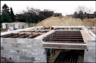
**29-41 (dahil) nolu maddelerde tanımlı izokal floor kat döşemesi uygulanmaz ise alternatif döşeme olarak Betonarme Plak döşeme yapılabilir..sadece düz ahşap veya çelik pano kalıpların montajı yapılır..**
