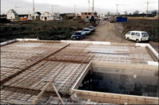
Kat döşemesi Üzerine statik programa bağlı ilave demir donatılar monte edilir ve kat betonu dökülür.
