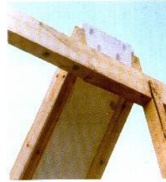
Yalıtım elemanları, çatı mahya açıklarına göre kesilirler.
