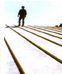
Yalıtım elemanları mertekler üzerinde, havalandırma lataları tesbit edilmiş.
