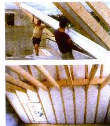
Kaplanmamış çatının içten görünümü
